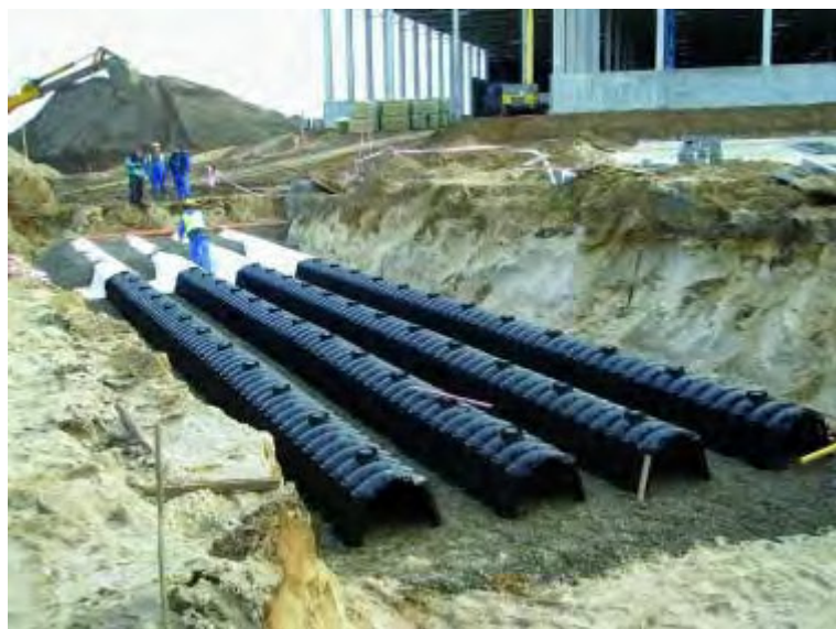
Esempio sistemi di accumulo
